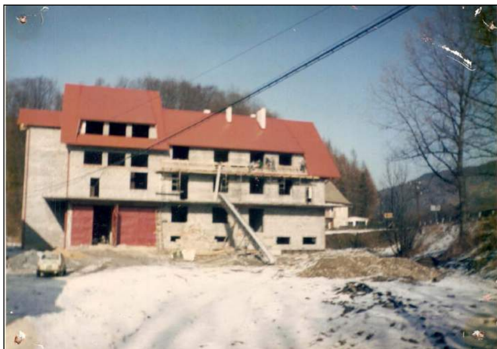
Nowa remiza w stanie surowym otwartym. Fot. Z archiwum OSP Stróża.
